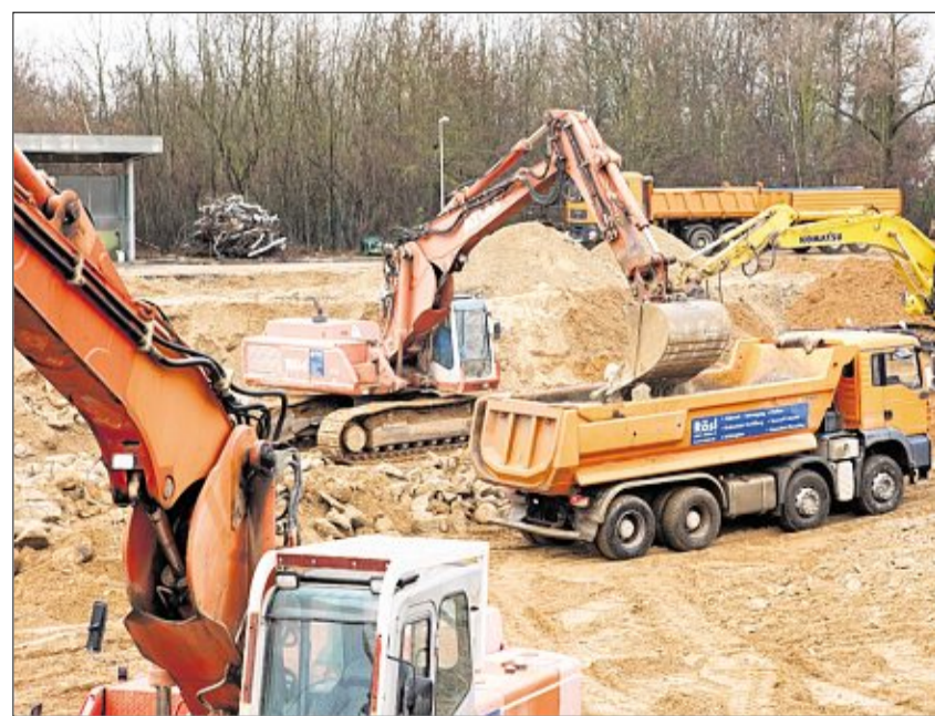
Kräftig gebaggert wird derzeit für das E.ON-Gebäude auf dem Baugelände an der Lilienthalstraße in Regensburg. Bild: osr
