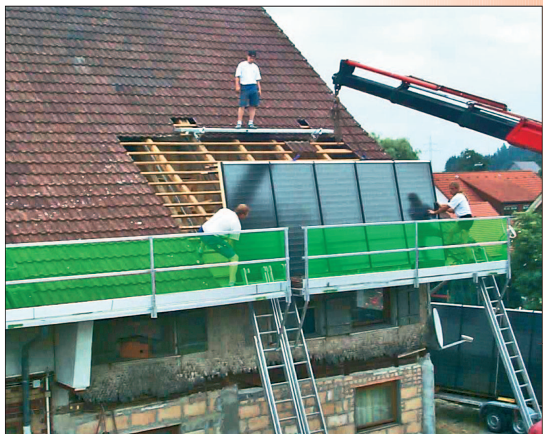
Das Bavaria-Leitern-Blitzgerüst im Einsatz: Zwischen zwei Leitern wird die Arbeitsfläche eingespannt. Foto: Mauderer
