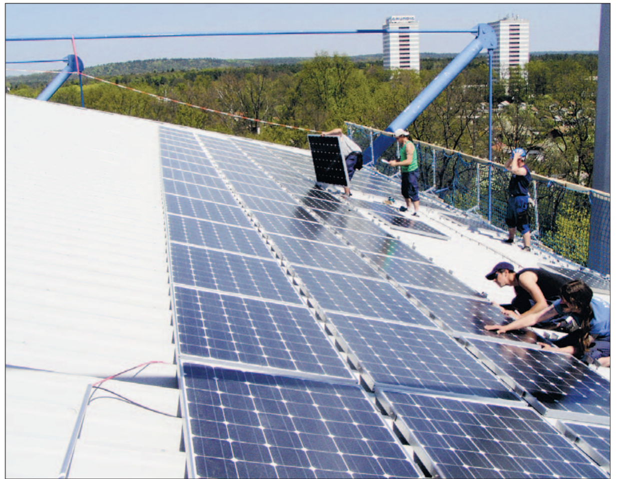
Montage einer Photovoltaikanlage auf dem easyCredit-Stadion in Nürnberg.
